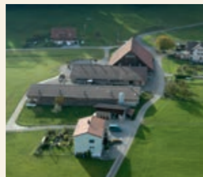
Landwirtschaft in Neuenkirch LU 100 kW Schnitzelheizung, Wärmeverbund
