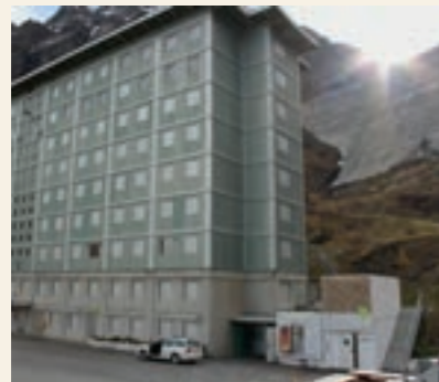
Grand Dixence in Hérémece VS 2 x 200 kW Pelletheizung, Dreifach-Heizcontainer
