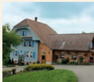
Bauernhaus in Grosswangen LU 39 kW Stückholzheizung
