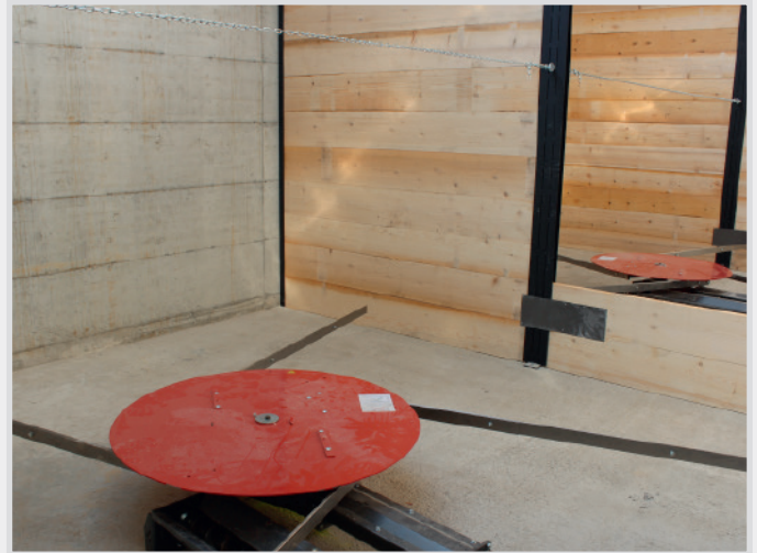
Trois cellules à bois déchiqueté avec système d'extracteur rotatif.
