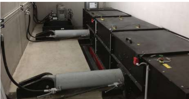
Massive Hydraulikzylinder zur Schubbodenbewegung
