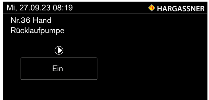
Nr. 36 Funktionsprüfung bzw. manueller Betrieb der parametrisierten Pumpe
