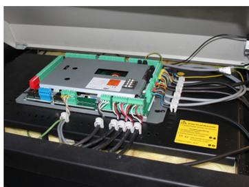
Beim Verlegen der elektrischen Leitungen außerhalb des Kessels (Hauptanschluss, Fühler, Pumpen / Mischersteuerung) auf den Mindestabstand zum heißen Abgasrohr und dem Saugzug achten.
