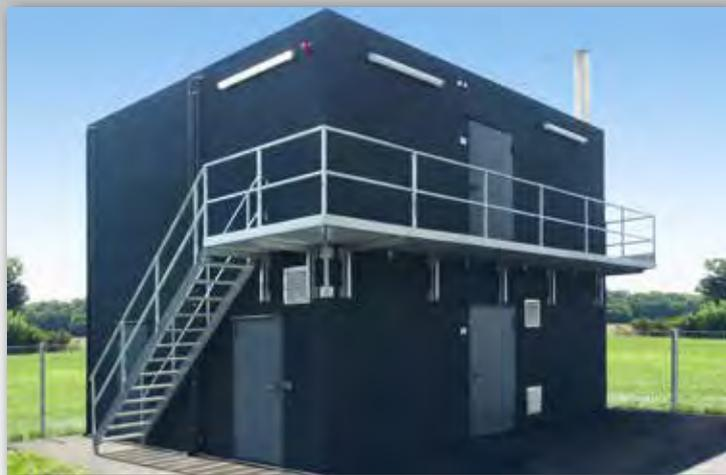
Container quadruple pour chauffer un bâtiment industriel.
