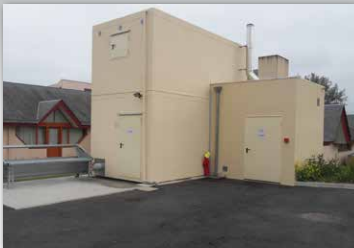
Container double accolé à une salle communale
