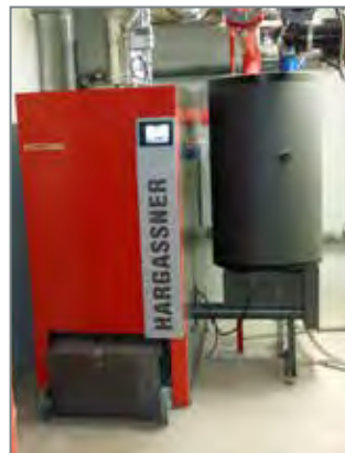
Chaudière EcoPK 150 kW avec RAS 350
