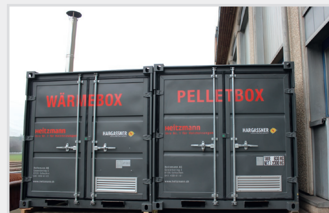
Containers installés côte à côte: box pour combustible et Energie-Box
