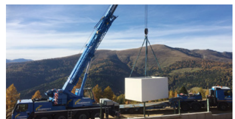
Versetzen mit Autokran
