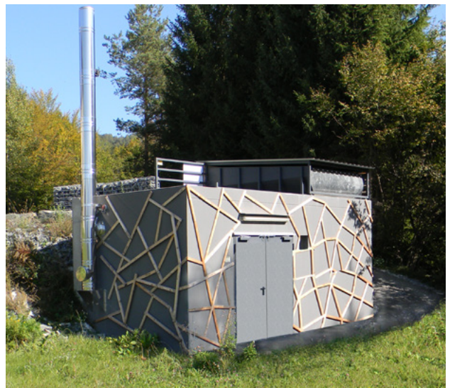
Regionalwärme Rosental (Contracting) in Ludmannsdorf, 200 kW Hackgut
