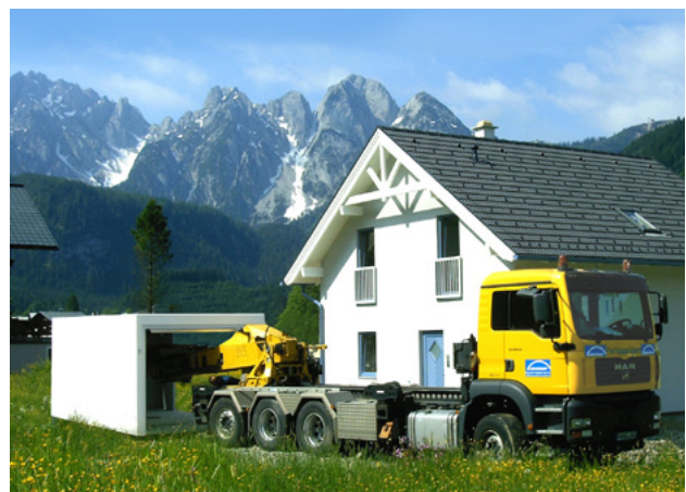
Für die Aufstellung der ECO-Box ist kein Autokran notwendig
