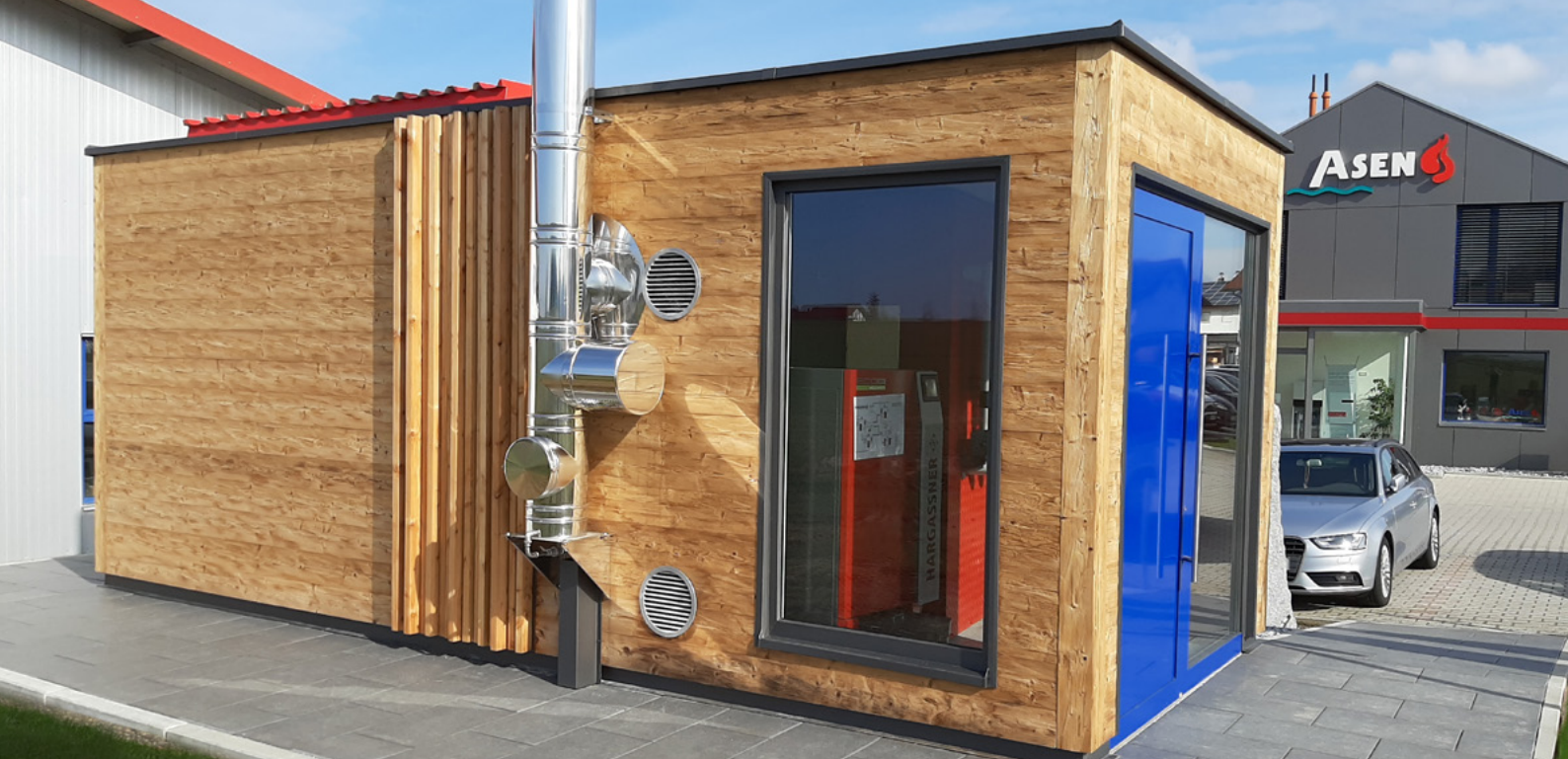
Asen Alois in Eging am See, 70 kW Hackgut
