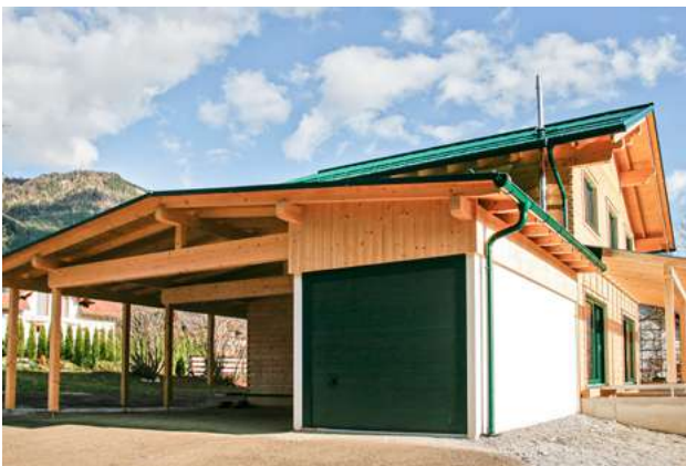
Eco-Box 9 kW Pellets, Einfamilienhaus
