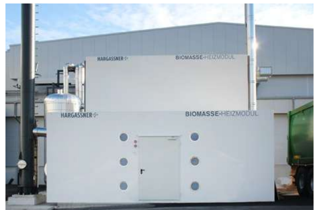
Mehrfach-Heizmodul 660 kW Hackgut, Industrie
