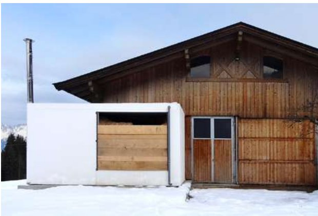
Einstock-Heizmodul 35 kW Hackgut, Landwirtschaft
