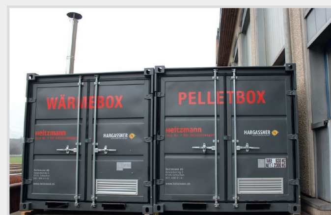
Container nebeneinander platziert: Brennstoff-Box und Wärme-Box
