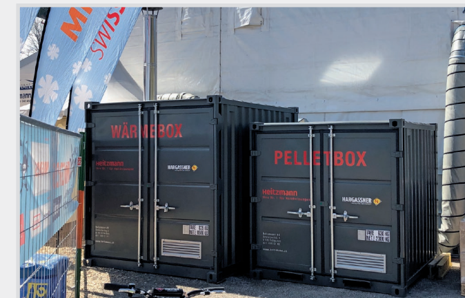
Mit dieser Wärme-Box wird ein Festzelt beheizt. Die Heizung ist in einem 10 Fuss Container, die Pellets sind in einem 8 Fuss Container.
