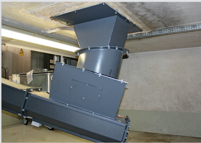
Une pièce de transition construite et produite par Heitzmann réunit les composants nouveaux et existants du chauffage.
