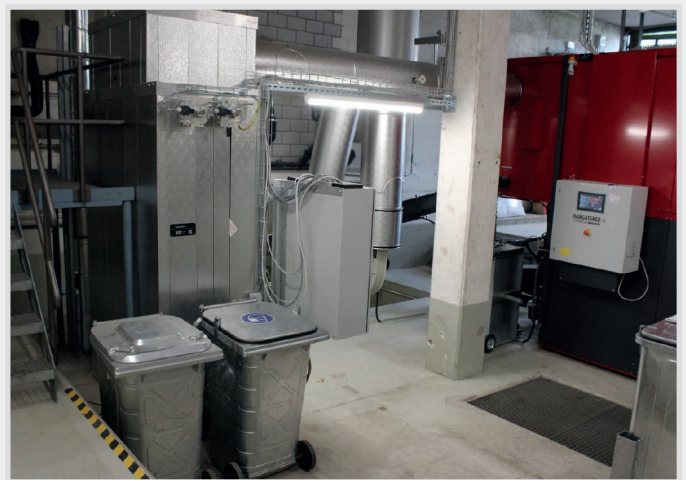
Feinstaubfilter von Meister mit der automatischen Ascheaustragung; diese fördert die Asche direkt in eine 240 Liter Tonne.
