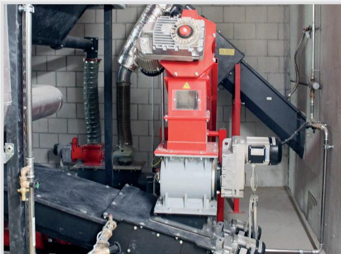
Die **Zellradschleuse** sorgt für eine **100%ige Rückbrandsicherung**. Die Einschubschnecken nach der Zellradschleuse fördern die Hackschnitzel kontinuierlich in den Heizkessel.
