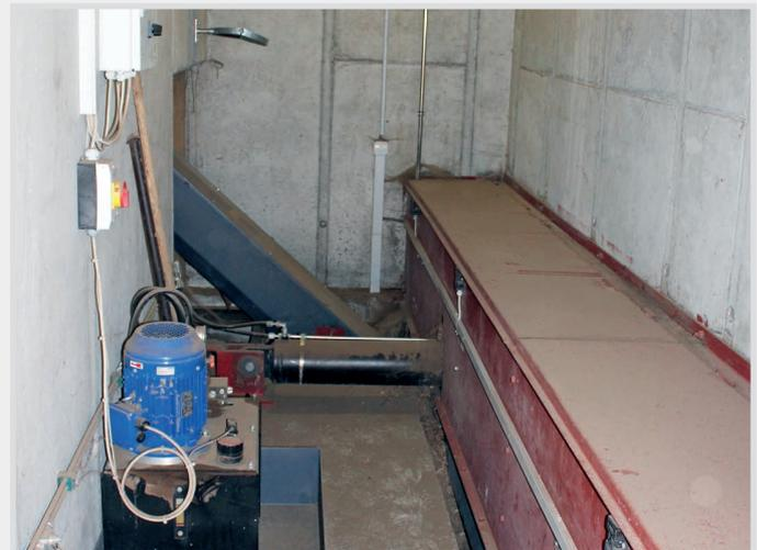
Der **Hydraulikraum** – das Herzstück der Schubboden-austragung – mit Hydraulikaggregat, Hydraulikzylinder und Querförderschnecke.
