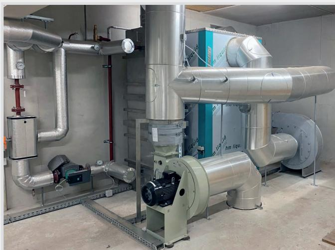
Der **Gewebefilter** und der **Saugzugventilator** des Heizkessels stehen im Stockwerk über dem Heizkessel. Ein grosser Vorteil des Gewebefilters ist der geringe Platzbedarf.
