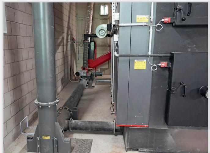
Ein **zentrales Aschefördersystem** transportiert die Rost-, Zyklon- und die Filterasche direkt in einen LKW-Container.
