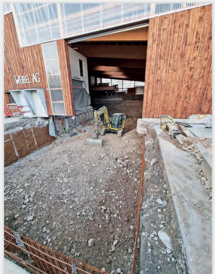
Aushub des Schnitzellagers und des Heizraum.
