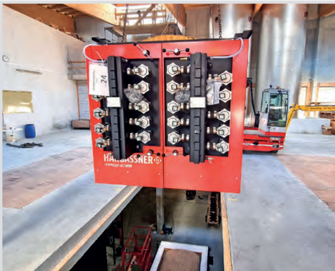
Einbringung Heizkessel über Öffnung in der Betondecke
