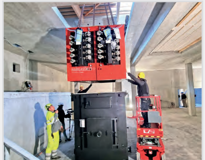
Zusammenbau Feuerbox und Wärmetauscher
