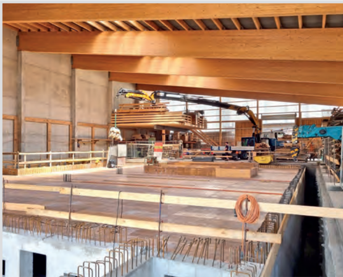
Betondecke über der Heizzentrale
