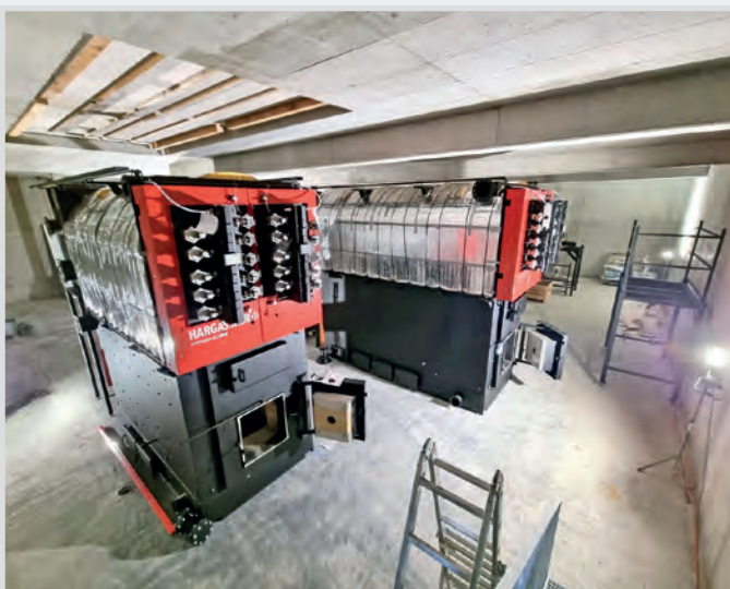
Beginn der Montage der Heizzentrale
