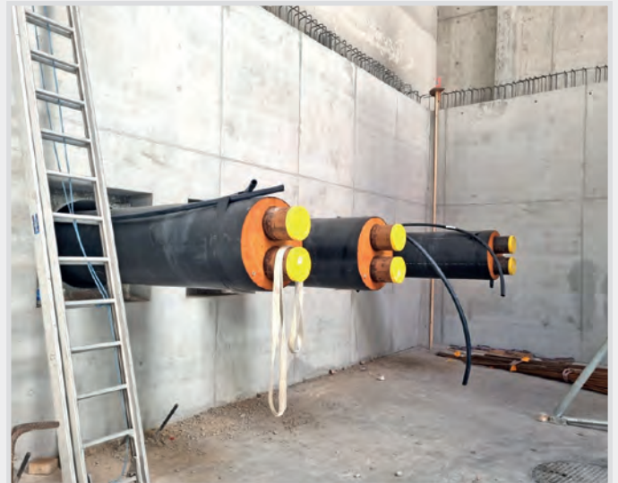
Fernleitungsrohre für drei Stränge
