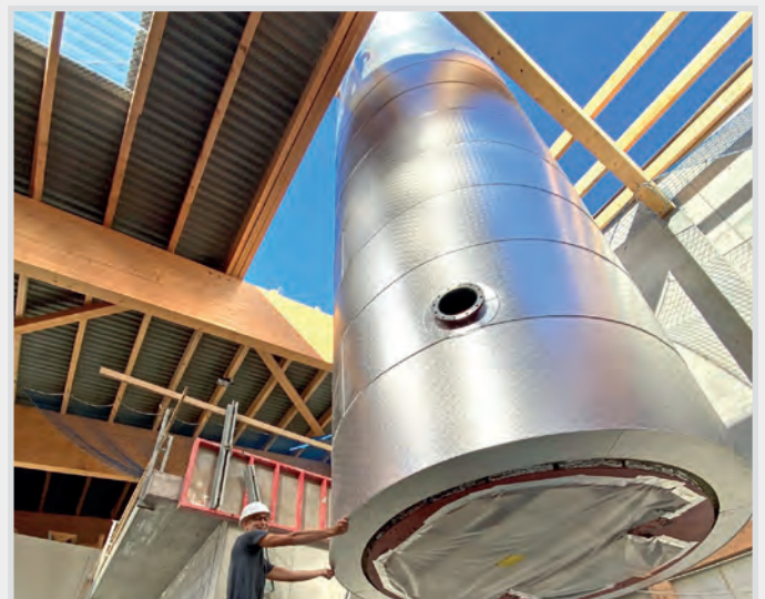
Einbringung Speicher über das Dach
